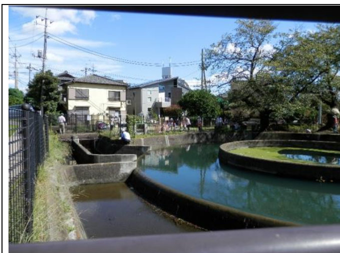
高津区久地円筒分水施設。 EM（有用微生物群）投入
